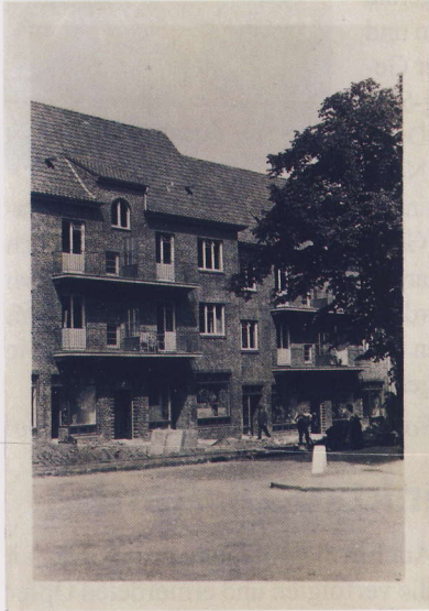
Kinoblock im Bau 1938/39
