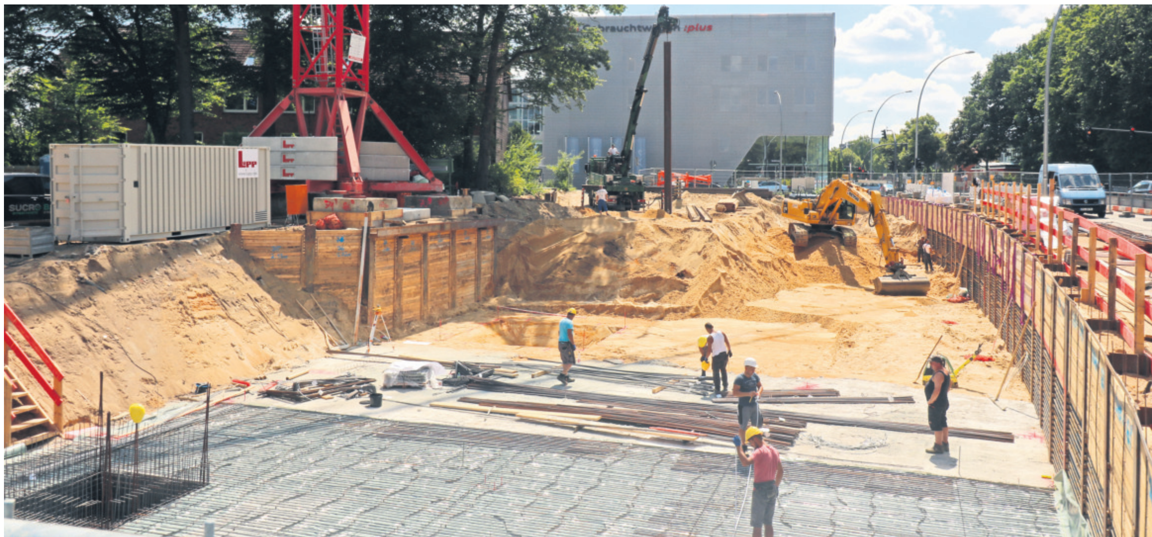
In Nachbarschaft zum Audi-Wichert-Zentrum entsteht ein neues Wohn- und Geschäftshaus an der Langenhorner Chaussee, Höhe Ochsenzoll
